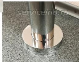
Основание -фланец имеет 135мм; комплектуется анкерами и колпачковыми (глухими) гайками М8-М10. Сварка производится по ГОСТу вольфрамовым электродом WL-20 с присадочной проволокой 1,6мм А2, в среде аргон.
