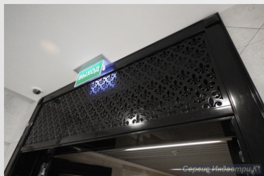
«Мотив Лилия» сталь, Ral Решетки панели приточно вытяжные рисунок «Лилия», Ral 9005 глянец
