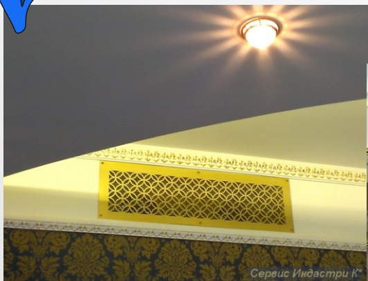
Латунные решетки приточно-вытяжной вентиляции «Мотив круги» латунь, сетка ПВХ, шлифовка
