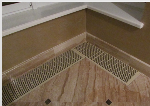
Решетка напольная, сталь 3мм кирпичик с закруглением
